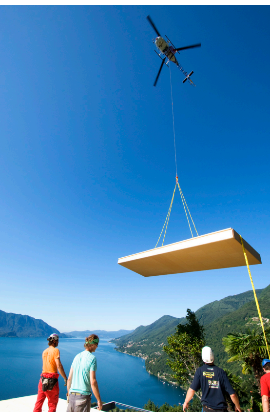
En quelques rotations, le plancher de la maison est terminé (Pierre Gillard).
