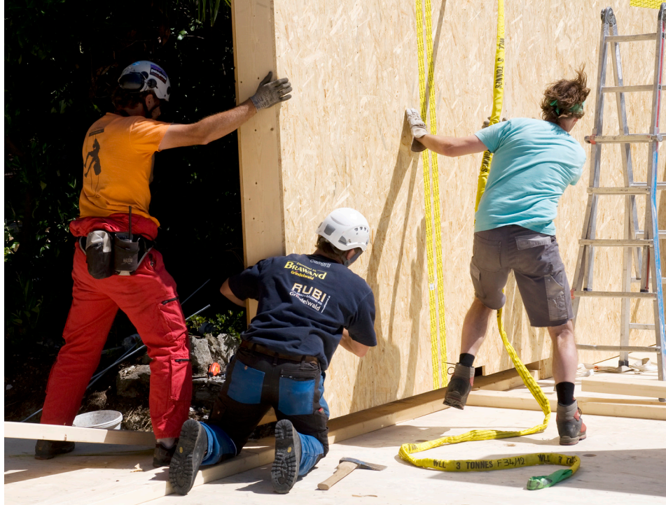
La mise en place des cloisons et des murs demande beaucoup d'adresse, non seulement de la part du pilote, mais aussi du personnel au sol (Pierre Gillard).
