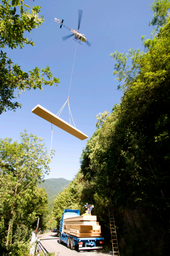
Un à un et dans le bon ordre, les éléments sont transportés par la voie des airs du camion au chantier (Pierre Gillard).
